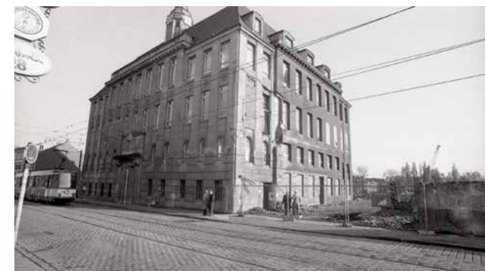
Ehemaliges Verwaltungsgebäude Gussstahlwerk, 1985. Foto: Alfons Kampert, ISG Gelsenkirchen
