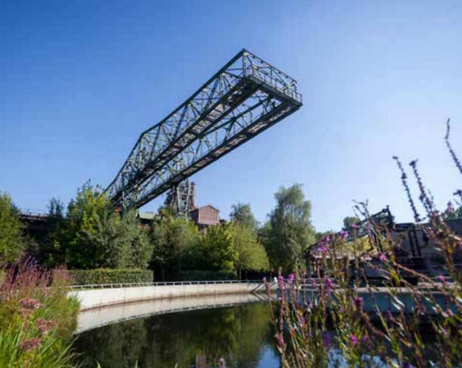
Kran über der Erzbunkeranlage. Foto: RIK/Kreklau
