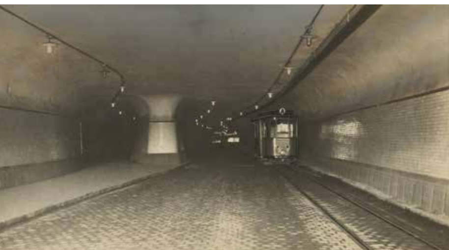
Matenatunnel 1930. Quelle: Stadt- archiv Duisburg
