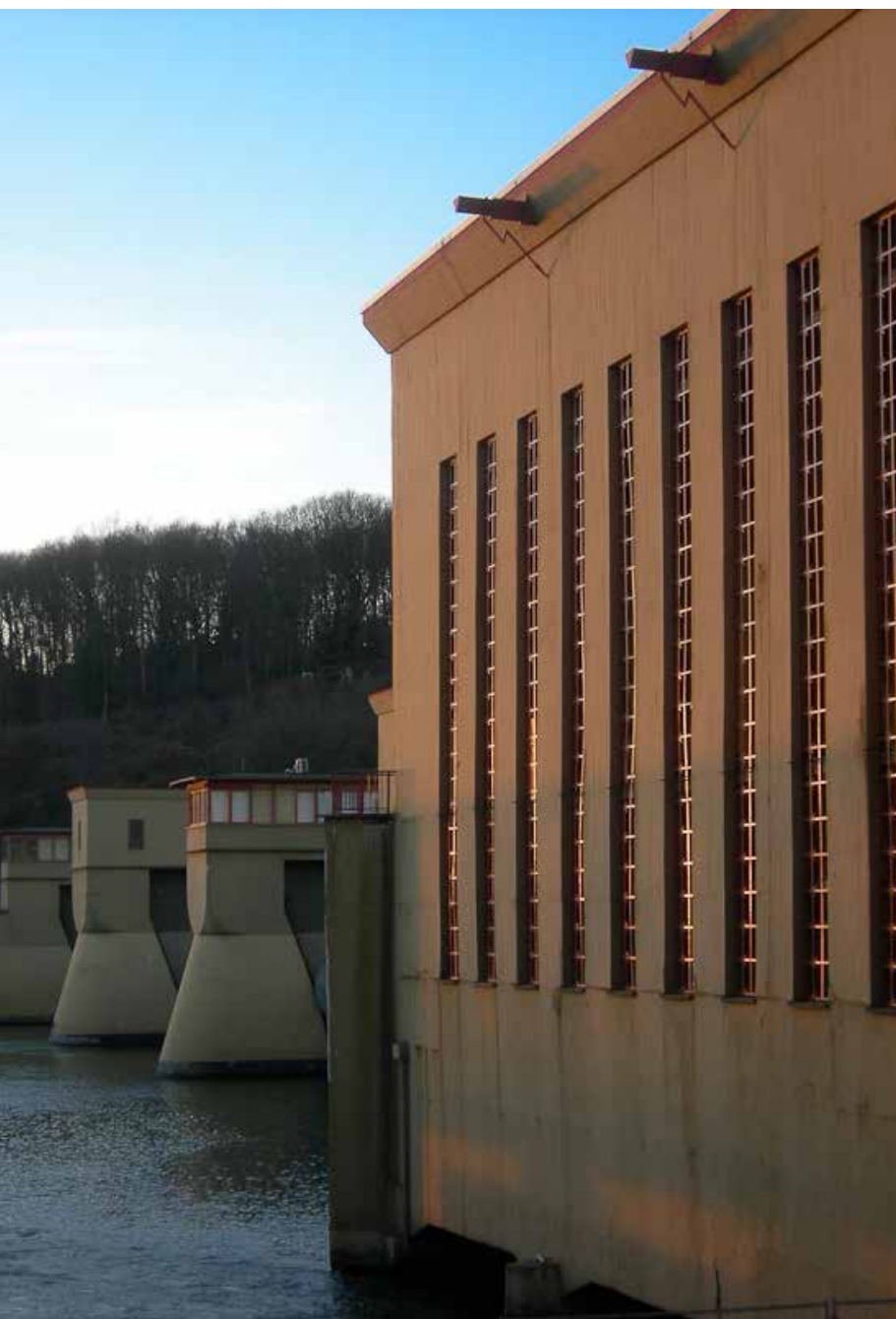
Laufwasserkraftwerk Hengstey. Foto: RIK/Budde
