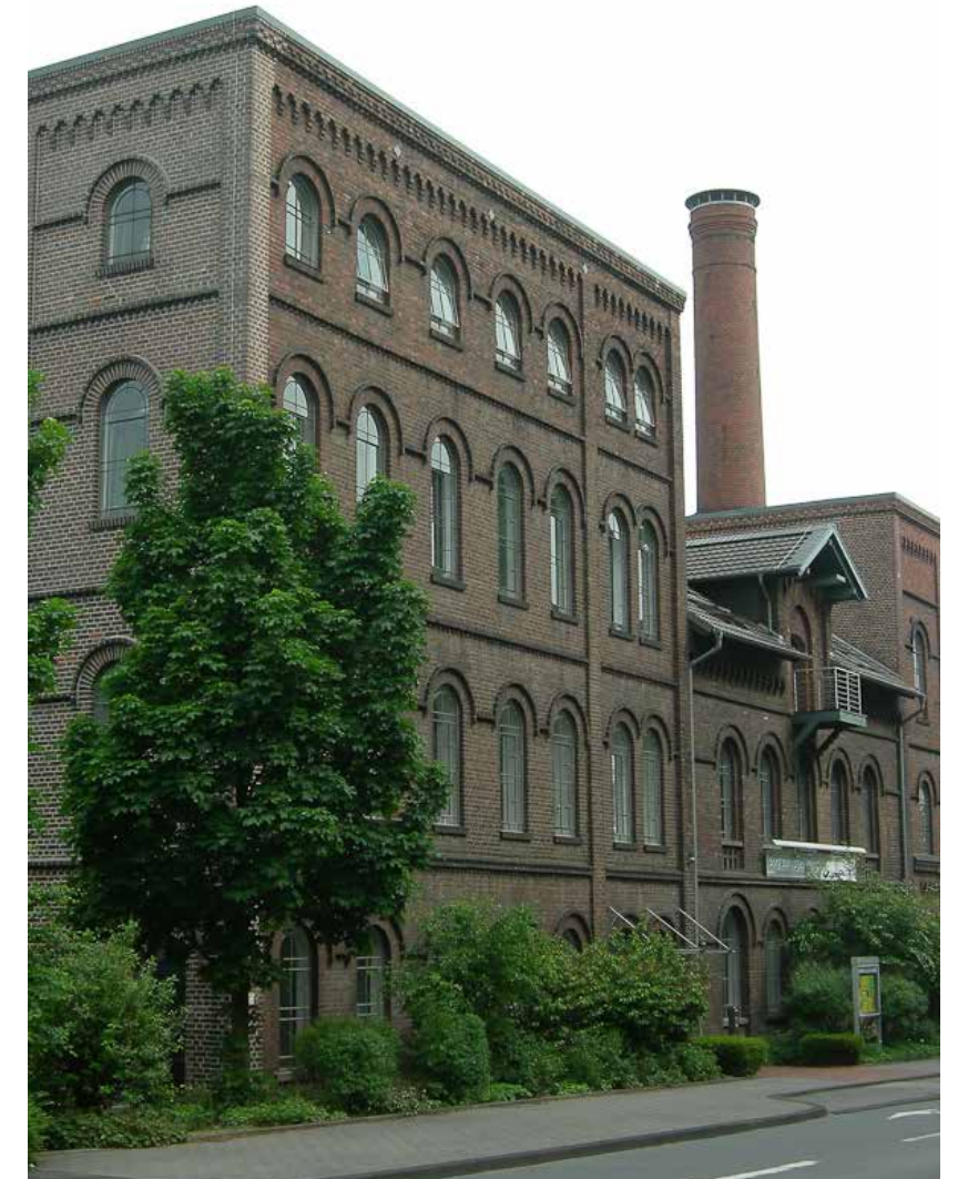
Ehemalige Kornbrennerei Niedernberg und Krüner Foto: RIK/Budde
