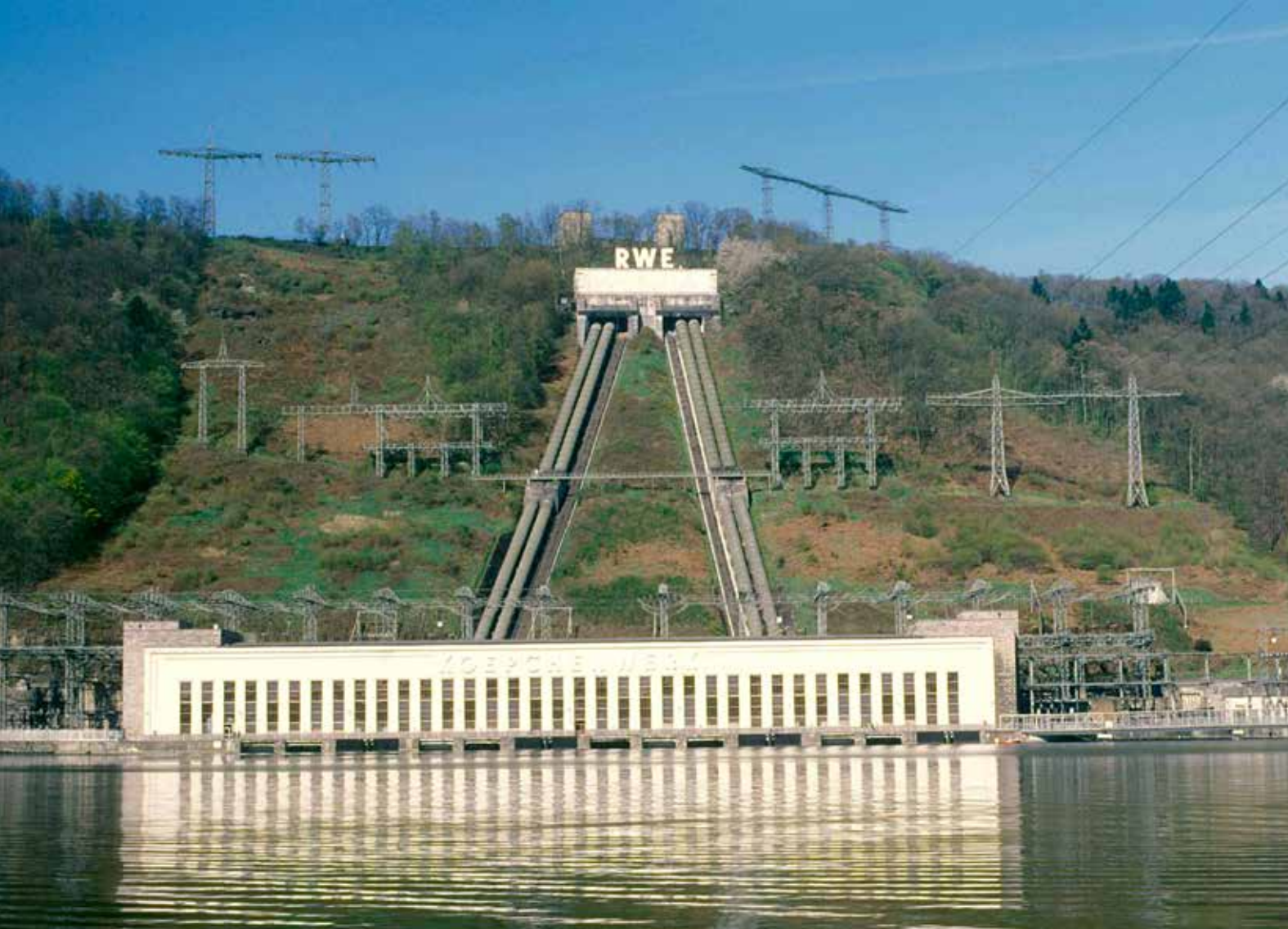
Pumpspeicher- kraftwerk Koepchenwerk. Fotos (2): RIK/ Reinhold Budde
