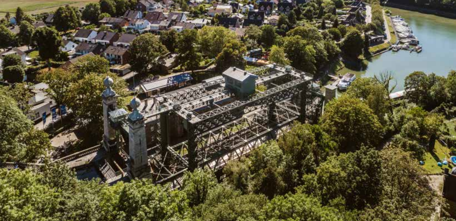
Schiffshebewerk in Waltrop. Foto: RIK/Staudinger
