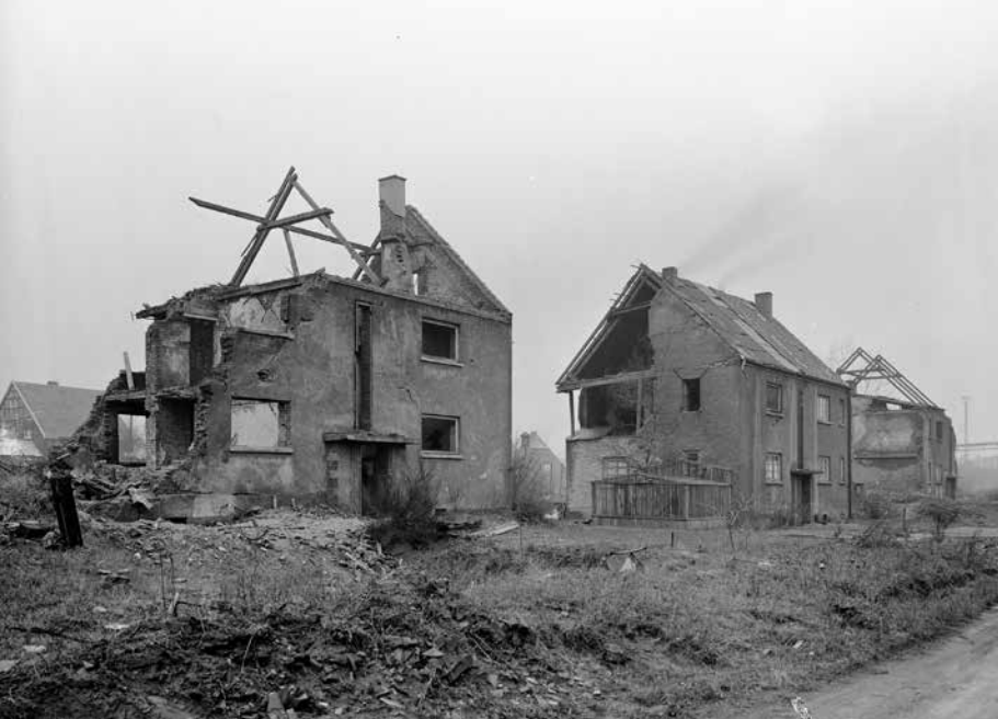
Kriegsschäden in der Scholven- Siedlung, 1949; Quelle: ISG
