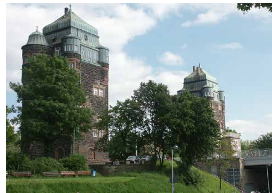
Friedrich-Ebert-Brücke. Foto: RIK/Walter
