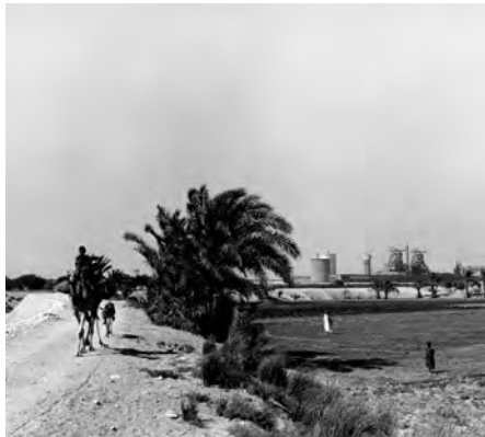
Hüttenwerk in Heluan, Ägypten Foto: Mannesmann-Archiv
